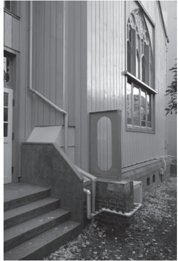
図11 存置されたバットレスの一部
