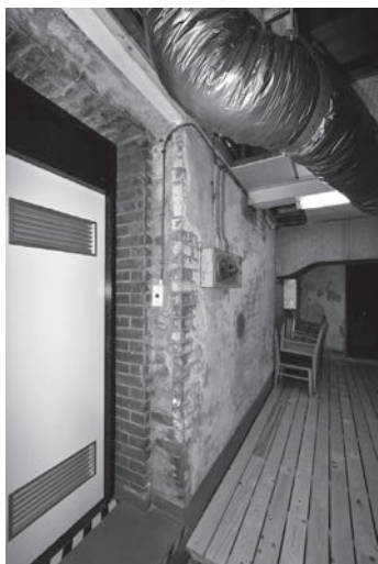
図2 煉瓦造の地階 現在は空調設備室や部材保管庫となっている。
