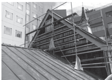
図7 妻壁に残る下見板一枚毎に間引かれて現存していた。
