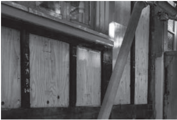
図13 構造用合板により補強された外壁
