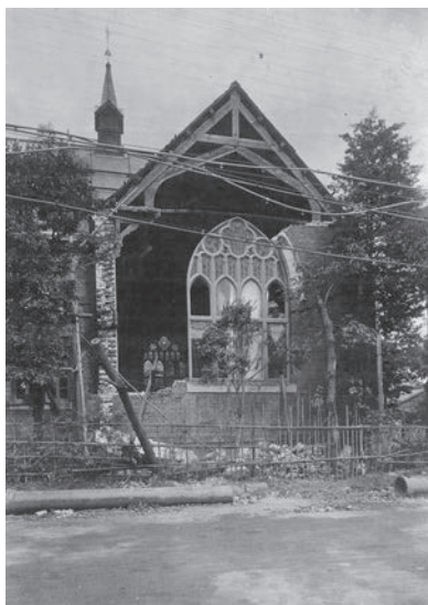
図5 関東大震災直後の様子
