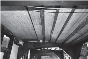
図14 側廊一階天井側からの補強
