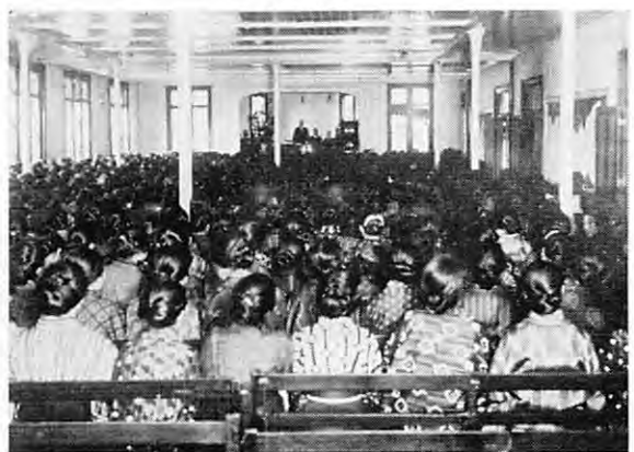
三類館の一階 応急処置とし、一時的に講堂として使用された。
