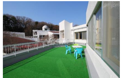
改修した高校校舎
