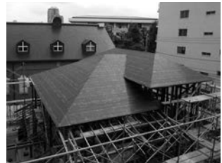
図37 下葺き(防水紙) 改質アスファルトルーフィング。
