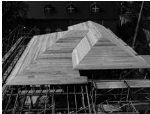
図36 野地板 瓦葺きの屋根下地完了。
