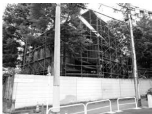
図20 外部足場・素屋根設置 解体用の仮設足場と仮設屋根。
