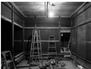
図 46 荒壁塗り 貫と同一面まで荒壁を塗る。乾燥後、裏側に裏返し塗りを行う。
