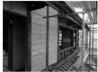
図43 耐震小舞 耐震補強のため厚さ約3cmの板を2枚貼り合わせた板壁を壁下地として設置。
