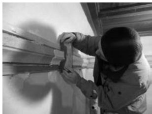
図 53 コーニス 蛇腹型引き 線型の型を作り、横に引いて仕上げる。
