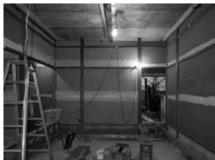
図 47 貫伏せ 貫廻りの補強。この後、底埋めと斑直しをして厚さを整える。
