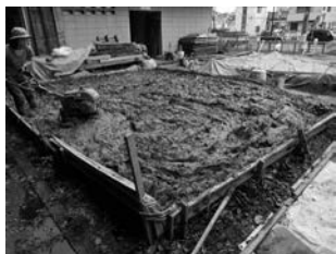
図 44 土練り 第2学生ホール脇にプールを作り、土に切葉を混ぜて長期間寝かせておく。
