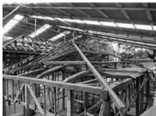
図23 小屋組解体 野地板・垂木を撤去した状態。
