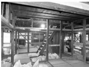
図22 壁解体 壁土と竹小舞を撤去した状態。
