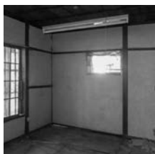
a. 修理前（壁）
