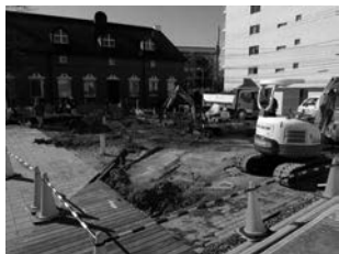
図29 敷地造成 現在の敷地を造成。
