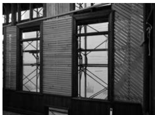
図 50 木摺下地 一部のみ木摺が斜めに打たれているのは、修理前の仕様に倣ったもの。
