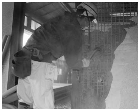
和室土壁の解体
