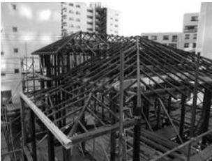
図35 小屋組 小屋組・野垂木が完了した状態。
