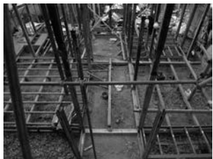
図24 軸部解体 1階床組を残した状態。
