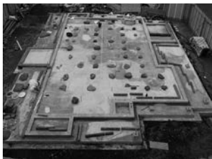
図31 耐圧盤・布基礎・礎石 厚さ30cmの鉄筋コンクリート耐圧盤 のうえに礎石を据える。
