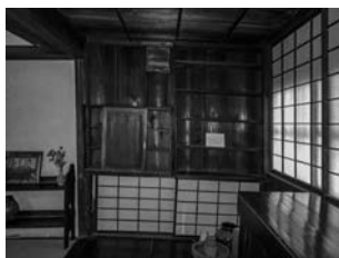
図19 移築前の建物すみ 激しい傾斜がみられる。
