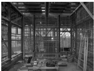
図 45 竹小舞下地 骨となる間渡穴を柱に差し込んで、小舞竹を並べ、縄で絡める。
