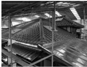
図39 屋根完了 瓦葺きと銅板葺き。
