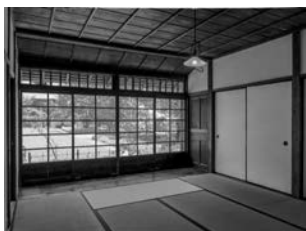
図9 1階 八畳 縁の障子を撤去して1室に改修。
