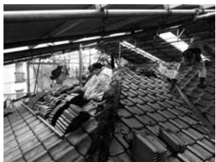
図21 屋根解体 瓦葺きの解体。瓦は再利用する。
