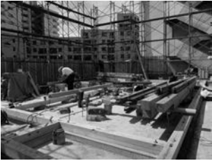
図32 土台据え・建方準備 土台を据えて、柱を並べ、建方の準備をする。
