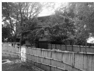
図17 移築前 正面 高い建仁寺垣に囲まれている。
