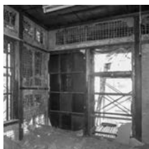
b. 解体中（壁中に旧建具）
