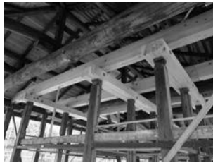
図42 補強梁 梁がない部分に設置。
