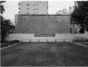
図38 素屋根 建方の後、屋根・左官・造作組立用の仮設屋根設置。
