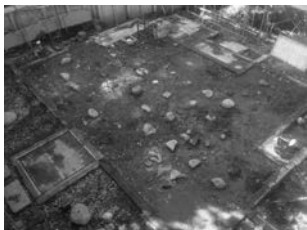
図25 木部解体完了 土台を撤去し、礎石のみの状態。
