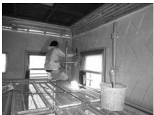
図 51 下塗り 尺トンボ伏せ込み 生漆喰を擦りつけ、尺トンボを打って砂漆喰で伏せ込む。
