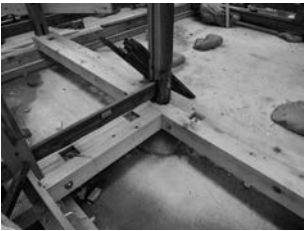
図41 補強地覆 土台がない部分に設置。
