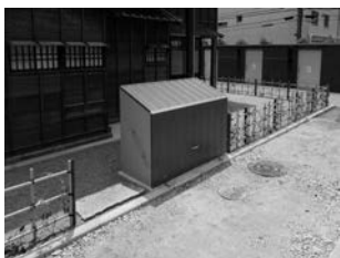
図 65 消防ポンプ収納箱
