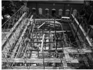
図33 建方 1階柱・2階床梁 長い柱は1～2階を貫く通し柱。
