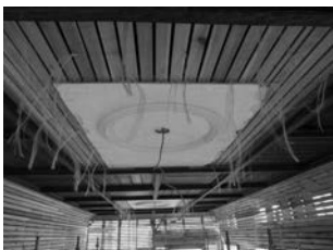
図 52 天井中心飾り 大ばらし解体した旧材を取り付け、周囲を塗って補修する。
