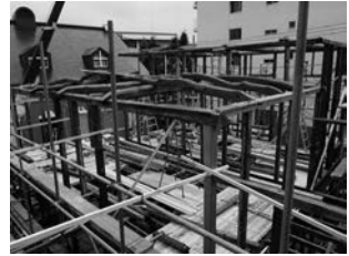
図34 建方 2階柱・桁・小屋梁 2階梁組が完了した状態。
