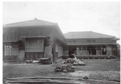
建設中の日暮里託児所（1919年10月）
